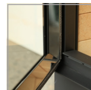
rama drzwi od wewnątrz wykończona stalą nierdzewną
