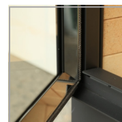
rama drzwi od wewnątrz wykończona stalą nierdzewną
