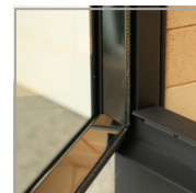
rama drzwi od wewnątrz wykończona stalą nierdzewną
