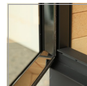
rama drzwi od wewnątrz wykończona stalą nierdzewną
